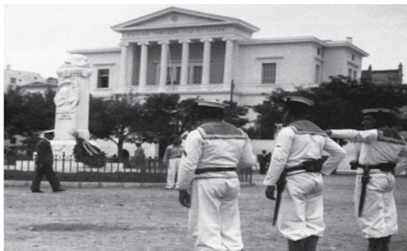
Το τρίτο χρονολογικά κτήριο που χρησιμοποίησε η ΕΤΕ ως κατ/μα στην Κέρκυρα, στην περιοχή της Σπηλιάς στο παλαιό Λιμάνι, με το τριγωνικό αέτωμα και τις έξι μαρμάρινες κολώνες στη βεράντα του α' ορόφου.
